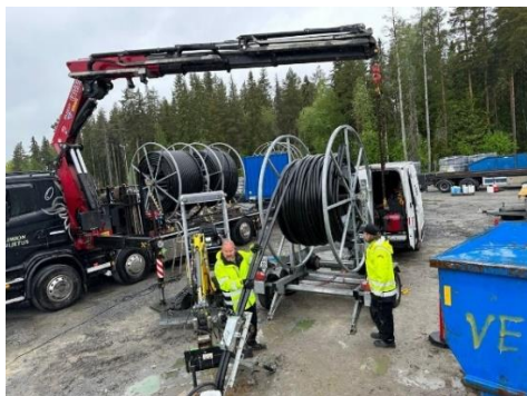
Fig. 1. Wykonanie otworowego wymiennika ciepła o głębokości 850 metrów
