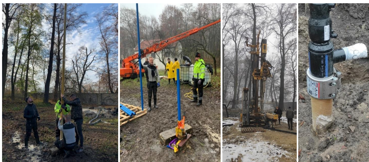
Fig. 3. Wykonywanie centrycznych otworowych wymienników ciepła na polu C Laboratorium Geoenergetyki w Młoszowej
