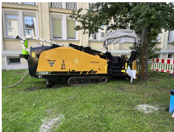
Fig. 1. Wiertnica HDD w czasie wiercenia poziomego otworowego wymiennika ciepła na terenie AGH
